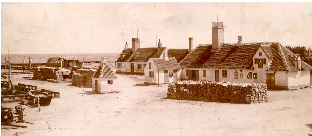
Foto af bygninger, havneplads, moler, både, ophalerspil og brændeoplæg. (DL, 1910)
